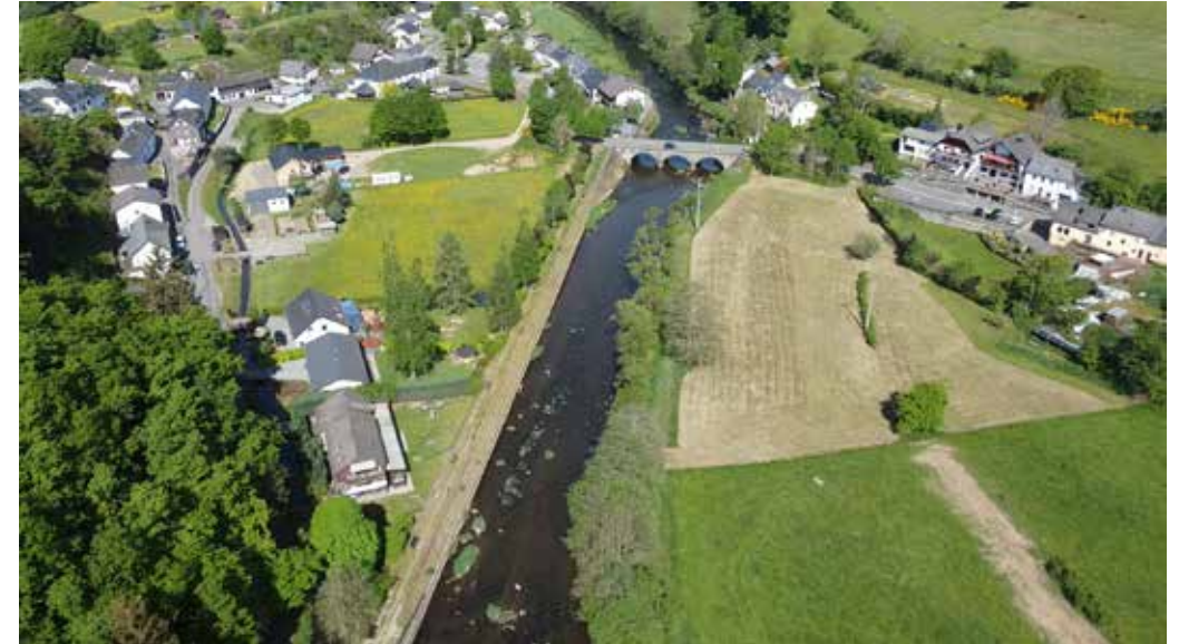
Dans la traversée du village de Ouren, le lit mineur de la rivière Our va être aménagé pour diversifier les habitats aquatiques
