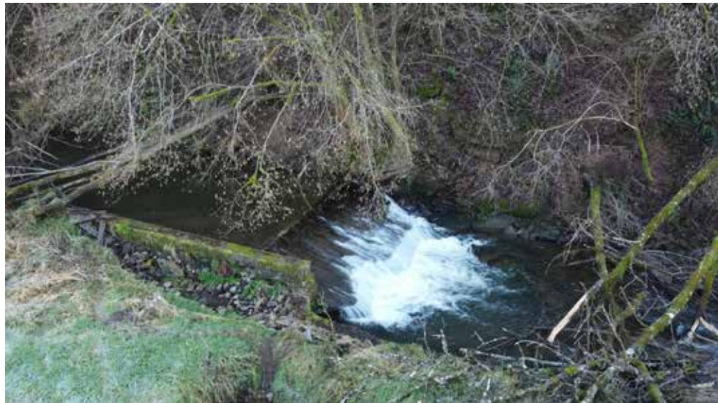
Barrage sur la Lembrée (bassin de l'Ourthe), dont l'aménagement est planifié pour faciliter son franchissement par les poissons
