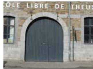
arc en pierre de taille autour d'un porche encadrement de portes et fenêtres
